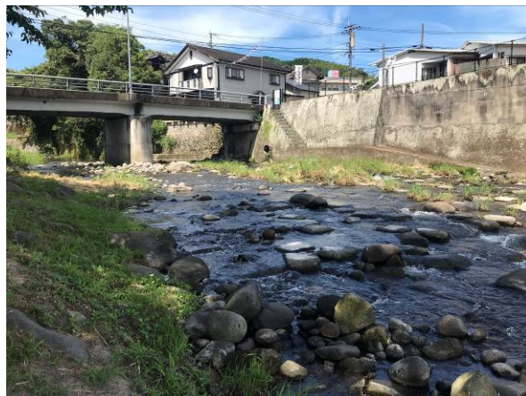
写真-2 上流(由布市 小野屋橋)
