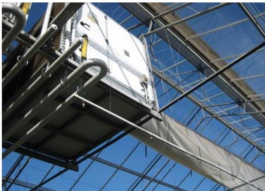
図-6 有機栽培 Greenhouse 内の暖房用送風機システム
