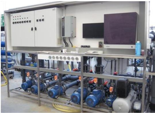
図-5 Greenhouse の養液供給・循環ポンプシステム
