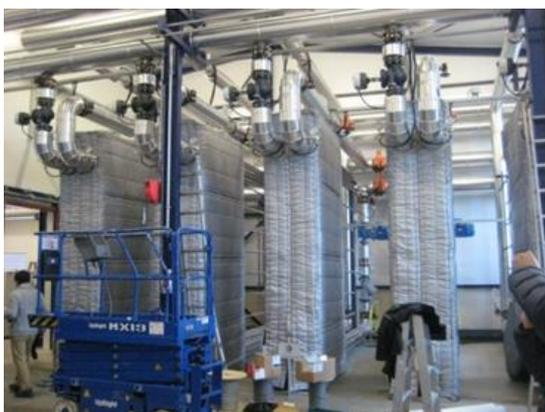
図-7 Greenhouse への地熱システム熱交換器
